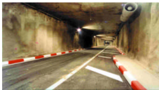
Tunnel de sortie
